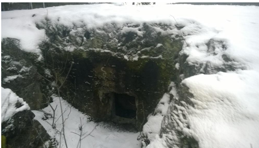
Kuva 20. Niemessä oleva rakenne, joka on todennäköisesti osa Salpalinjaa
